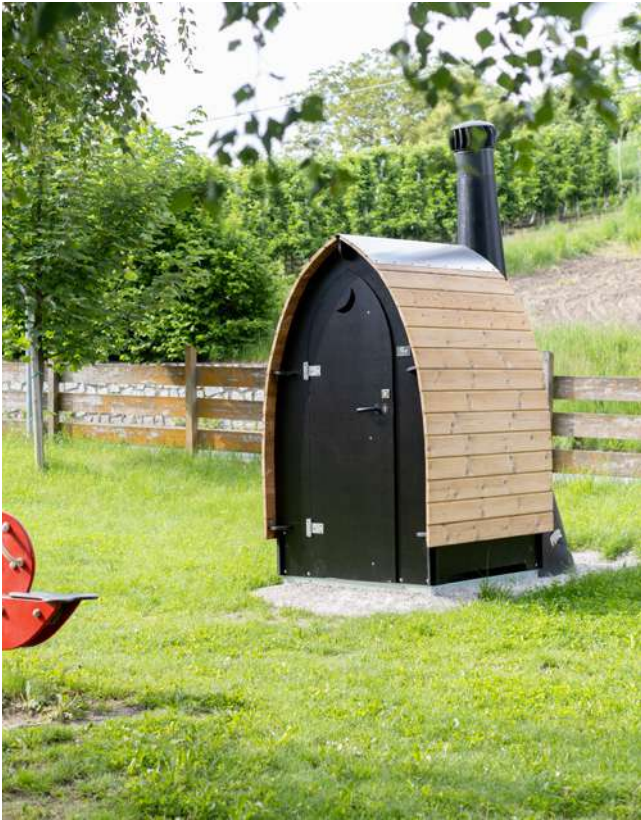
Am Spielplatz Hintersun wurde eine neue Trockentoilette installiert
